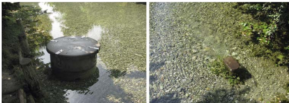
Figura 7. Tini in cemento con copertura e tubi metallici commerciali adattati
