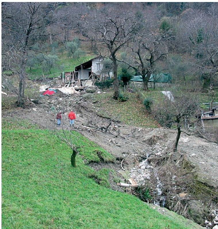
Fig. 41 (colonna sinistra in alto): Civate (LC), dissesto avvenuto il 18/11/1996 in terreni di copertura. Il fenomeno si è verificato a seguito di forti piogge che hanno saturato i terreni di riporto soprastanti l'abitazione.
