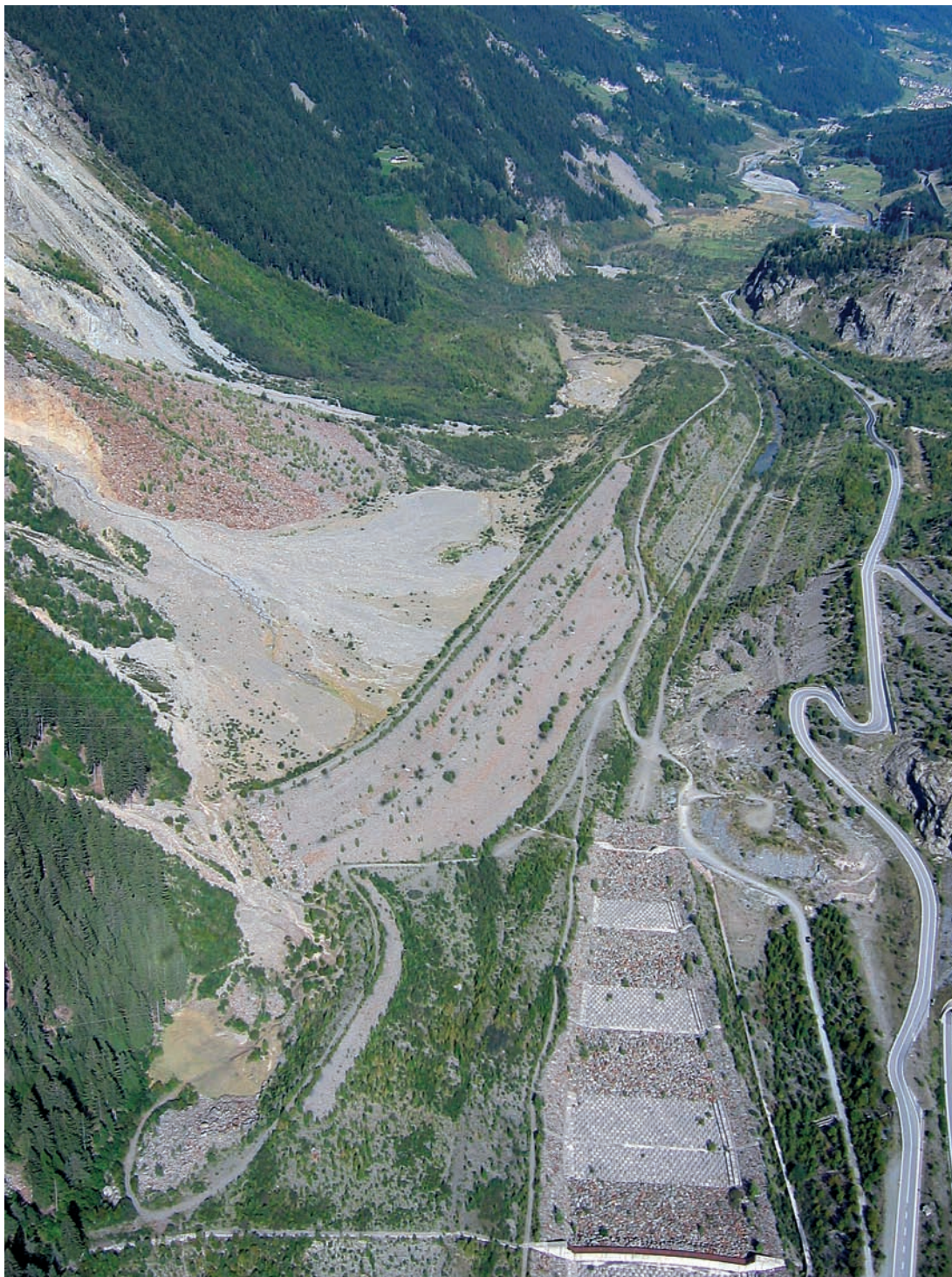
Fig. 82: Val Pola (SO), sistemazione attuale della rock avalanche. Si possono osservare il rilevato costruito alla base del versante, la sistemazione del tratto di alveo del fiume Adda con una serie di briglie e il by pass dello stesso.
