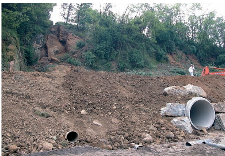
Fig. 46: Carenno (LC), sistemazione con teli impermeabili di uno scivolamento planare avvenuto nell'agosto 2000.
