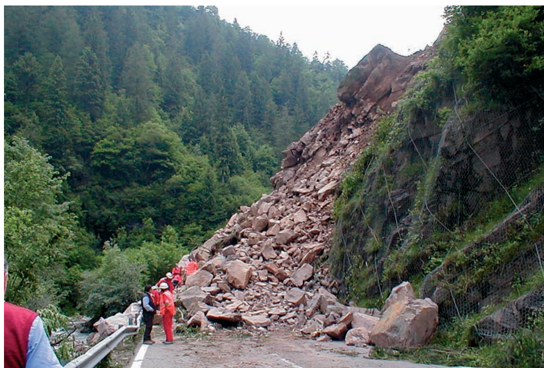
Fig. 50: Collio (BS), accumulo della frana del 4/06/2002. Il volume complessivo di materiale coinvolto nell'evento è di circa 2000-3000 m 3 il volume totale dell'accumulo di circa 1000-1500 m 3 .
