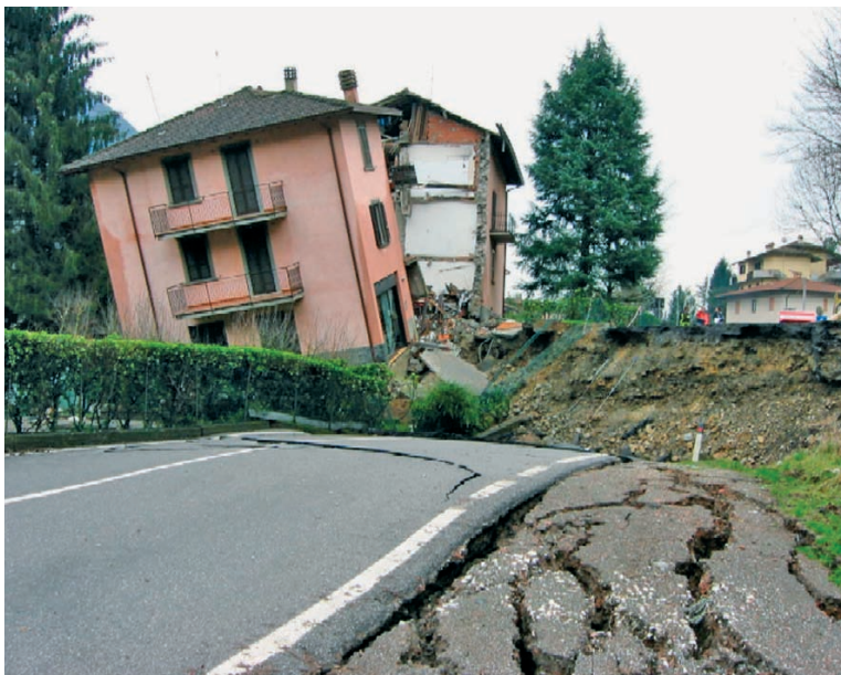
Fig. 44: Capizzone (BG), la frana del novembre 2002 ha provocato la distruzione di numerosi edifici e della sede stradale.
