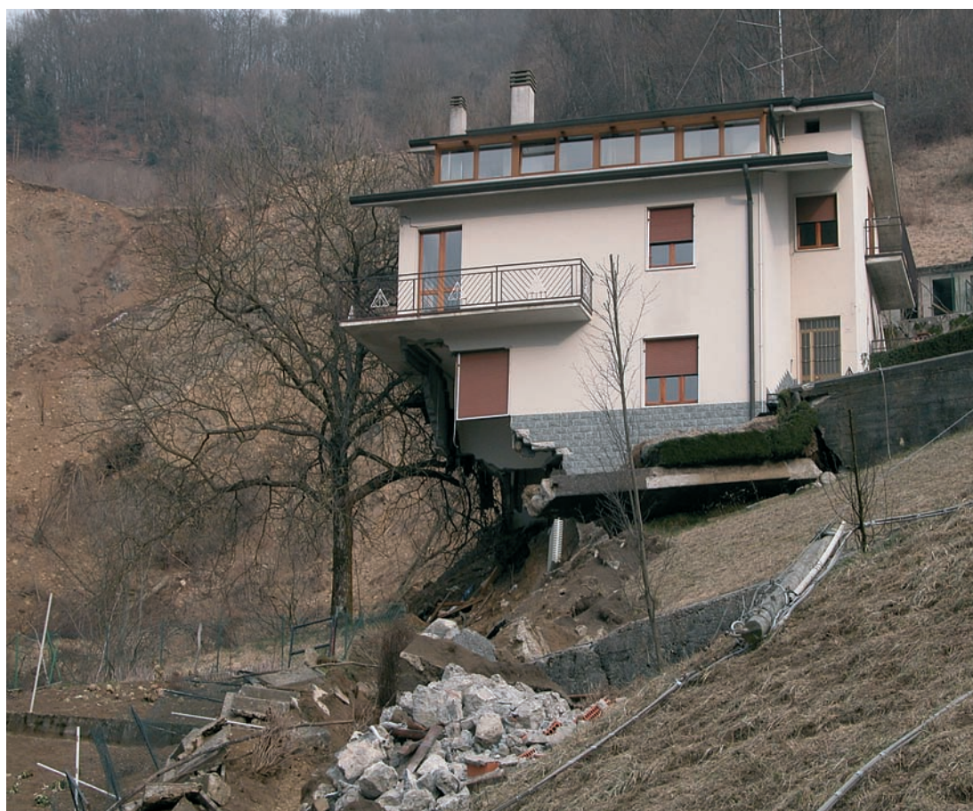
Fig. 45: Camorone, Brembilla (BG), scorrimento rotazionale. L'evento del novembre 2002 ha provocato la distruzione di numerosi edifici.
