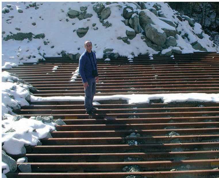
Fig. 62: Dorfbach, Vals, Svizzera, griglia selettiva per il deposito del materiale della colata.
