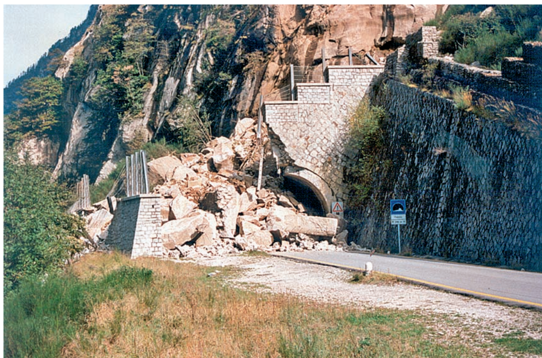
Fig. 20: San Giacomo Filippo (SO), crollo di circa 1500-2000 m 3 . IL crollo in massa ha distrutto la galleria paramassi della strada SS 36.
