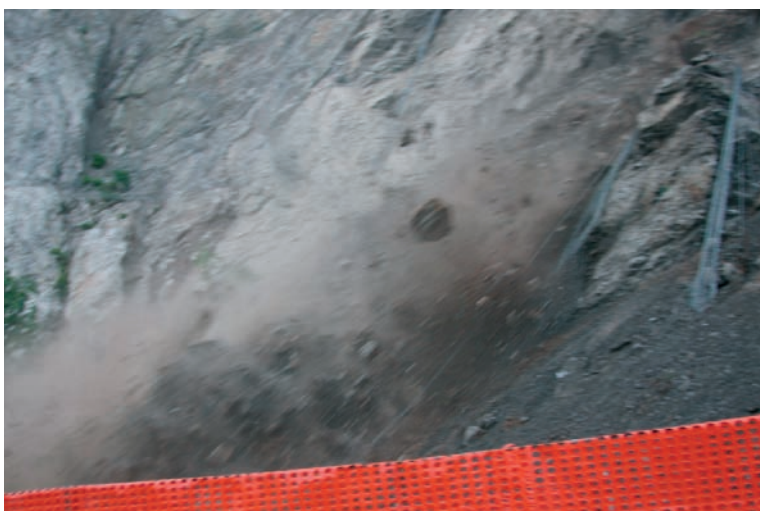
Fig. 14: crollo in roccia.
