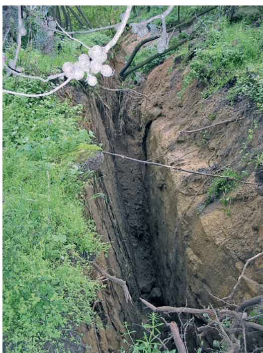
Fig. 32, 33, 34: Capriolo (BS), particolari dello scorrimento avvenuto il 7 maggio 2004. Nella foto in alto si osservano i blocchi ruotati, nelle foto in basso le fratture aperte. La superficie di scivolamento è situata a circa 15-20 m di profondità. I blocchi hanno subito uno spostamento verticale di circa 4-5 m e orizzontale di circa 1-10 m.
