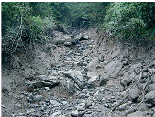
Fig. 56-57: Sonico, Savio- vire dell'Adamello (BS), caratteristiche del cana- le di trasporto da de- bris flow del T. Zazza. Il fenomeno è avvenuto nel luglio 2003. Si pos- sono osservare le ripide scarpate (2 m) forma- te dall'escavazione del materiale trasportato e la disposizione del ma- teriale.
