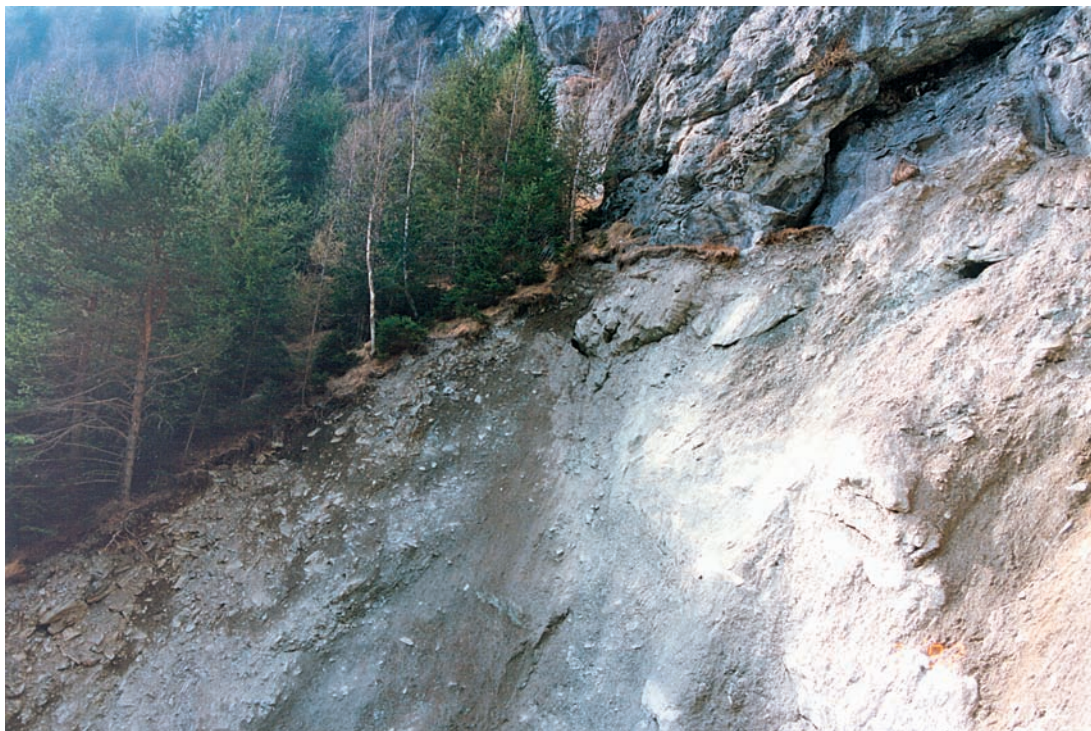
Fig. 66 : Campo Frasca, Lanzada (SO), zona sommitale dello sprofondamento. Il materiale detritico è scivolato lungo la superficie visibile sulla destra della foto.
