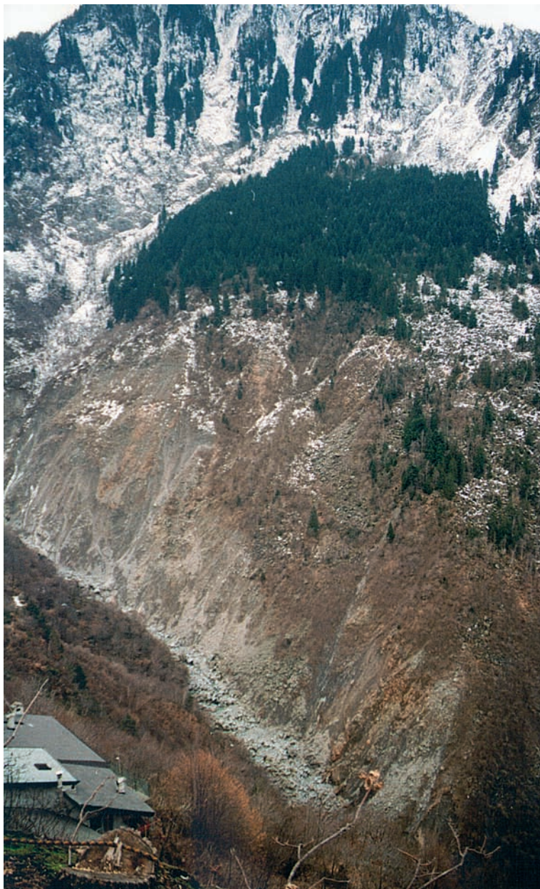
(in alto a sinistra) Fig. 90: loc. Chiuso, Lec- co, pareti subverticali in area di ex cava da cui si sono verificati diversi crolli, con volumetrie dei massi variabili da alcuni dm 3 ad alcuni m 3 .
