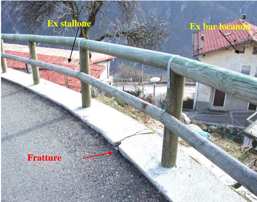
Fig. A105 - Panoramica ripresa da monte della porzione di versante compresa tra l'ex stallone e l'ex Bar Locanda con in evidenza le fratture riconducibili al fenomeno franoso in atto.
