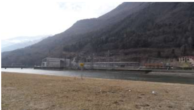
Fig. A109 – La centrale idroelettrica di Cimego.
