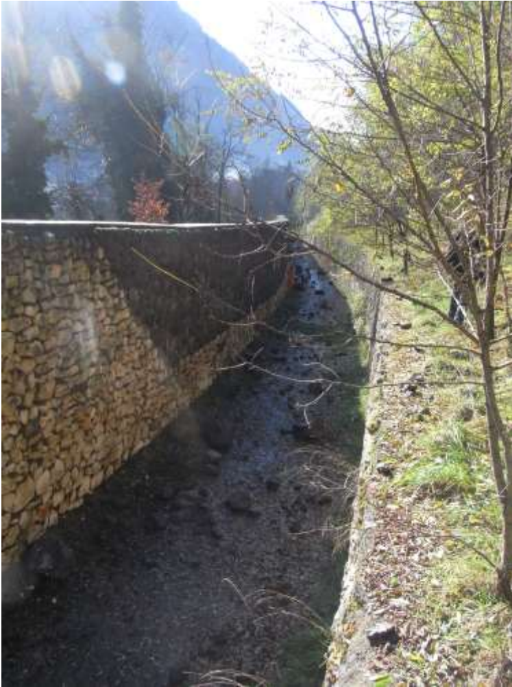
Fig. A99 – Prospettica del vallo e del tomo in muratura a difesa dell'abitato di Condino (foto R. CAMPANA, 2010).
